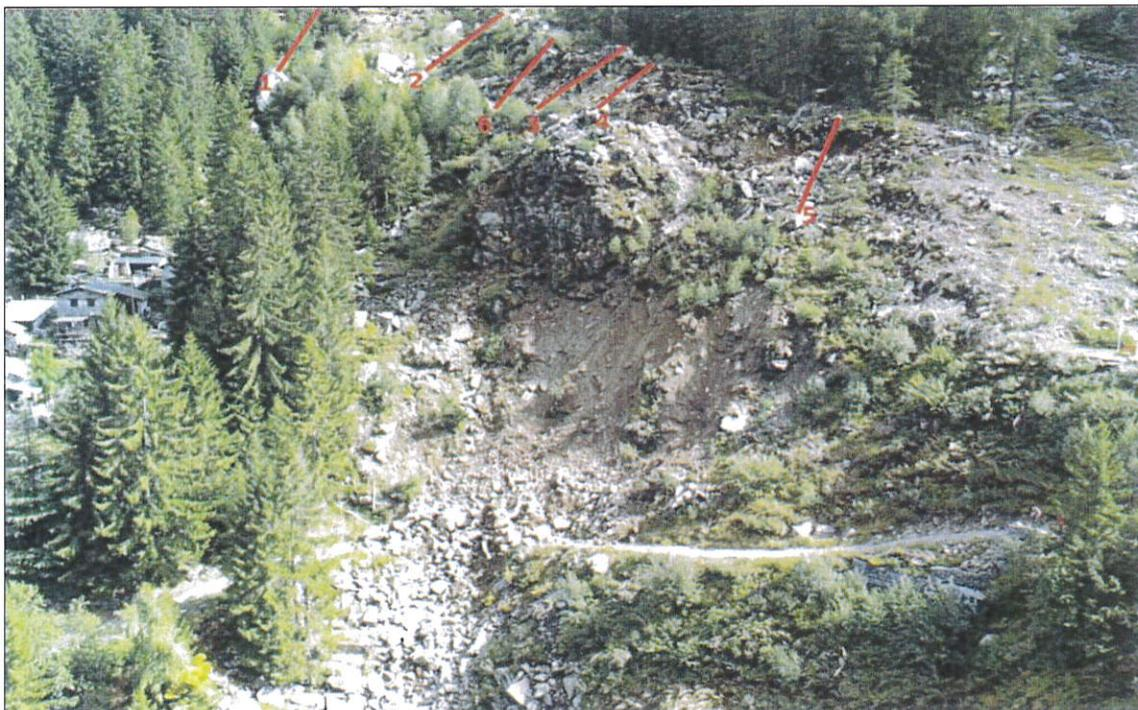
Figura 2. – processi di crolli in corrispondenza della scarpata principale sopra la strada forestale, presso il nucleo di Biborgo. In rosso la posizione degli estensimetri.
